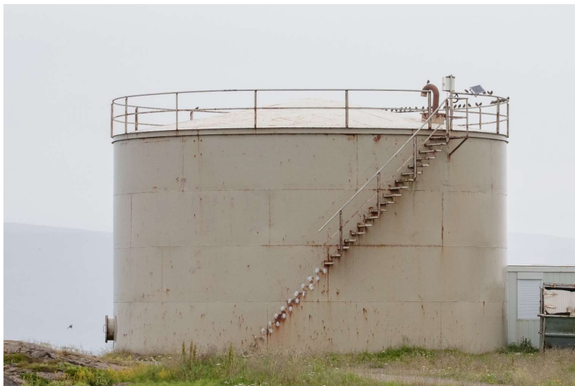
Mynd 14-2 Vatnsveita í Búðardal.
