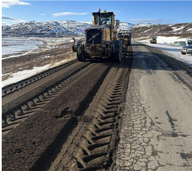
Mynd af vef Vegagerðarinnar, frá mars 2024 þar sem verið var að hefja og þjappa slitlag (klæðningu) sem búið var að fræsa saman við burðarlög.
